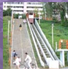
양재천 경사형엘리베이터 INCLINED ELEV.
